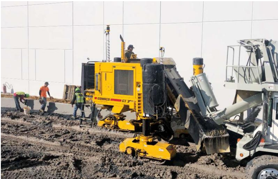
全長16フィート（4.88 m）のコンベアは、最大ベルト速度毎分284フィート（86.6m）でホッパーに材料を供給することで、高さ21インチ（533 mm）のスタンドアップカーブの打設を支援します。
