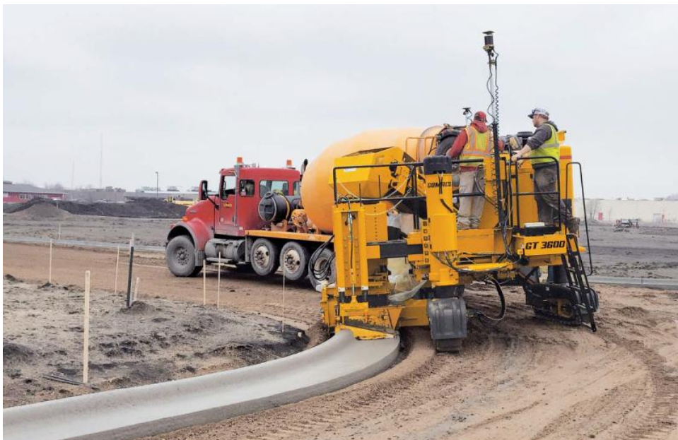
GT-3600の最大毎分42フィート（12.8m）の施工速度により、高生産カーブアンドガッターの施工が可能となります。
