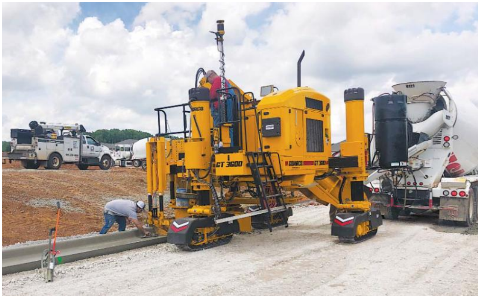
エクストリームGT-3600が、新しい分譲地にて3Dマシンガイダンスを使用してカーブアンドガッターを打設しています。
