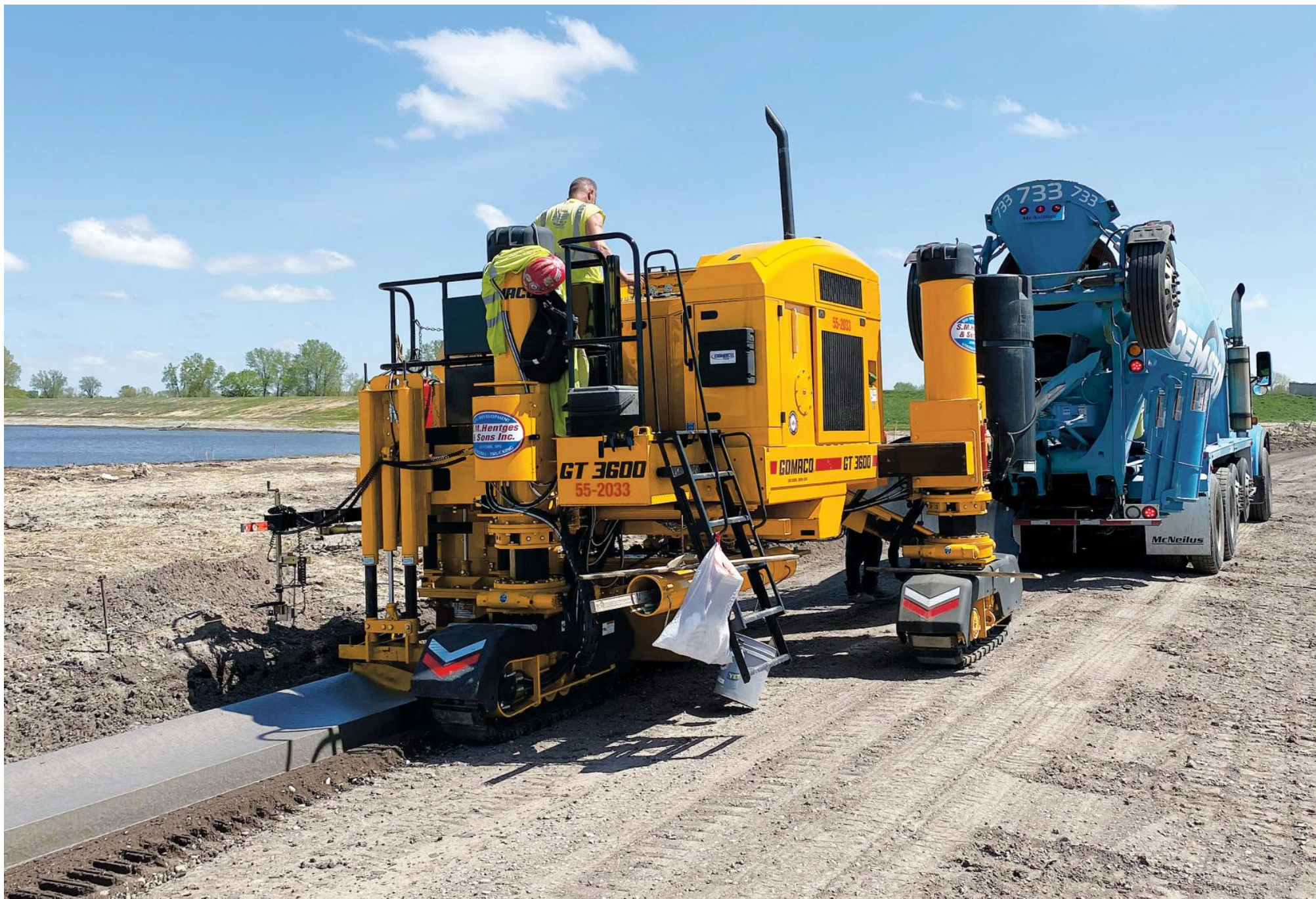
エクストリームGT-3600が、新開発地域にてロールオーバーカーブを打設しています。
