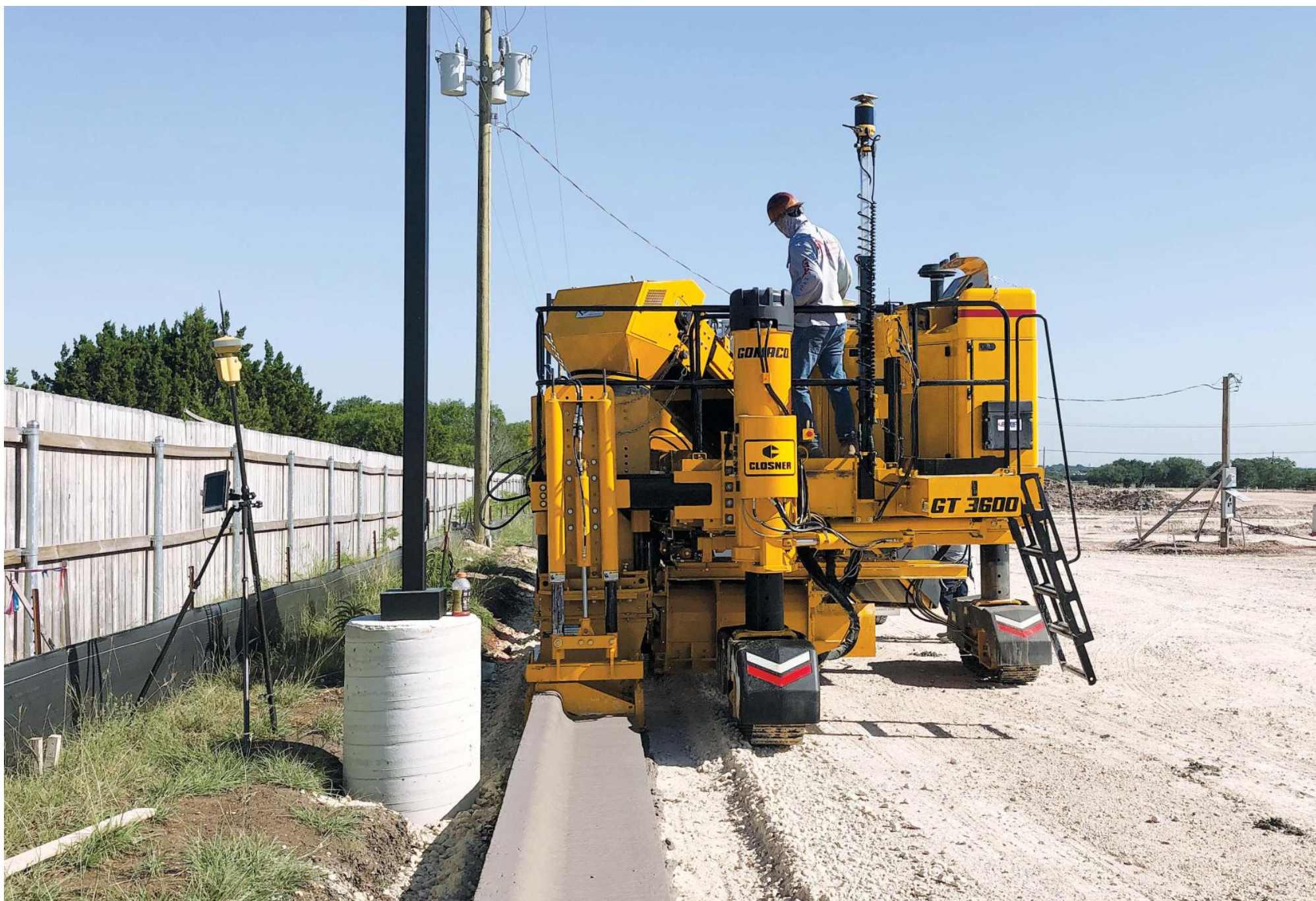
3Dマシンガイダンスにより、最小限のクリアランスを確保できるため、既存の公共設備が障害となる現場でも、ストリングラインを設置する必要はありません。
