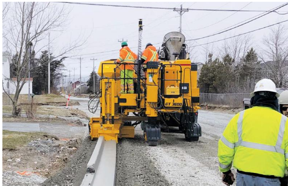
3Dマシンガイダンスを装備したGT-3600を使って、既存の住宅地域にカーブアンドガッターを打設しています。作業中に既存の車道を遮断できるため、後処理の手間を省くことができます。
