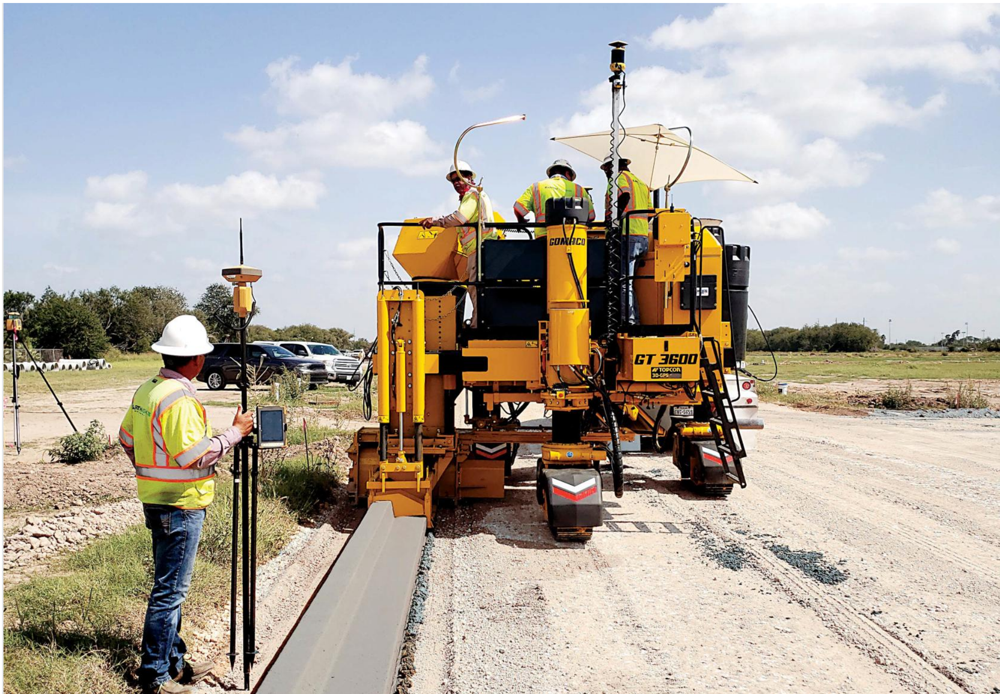
新しい住宅地開発の現場にて、エクストリームGT-3600が3Dマシンガイダンスを使用して、18インチ（457mm）のカーブアンドガッターを打設しています。
