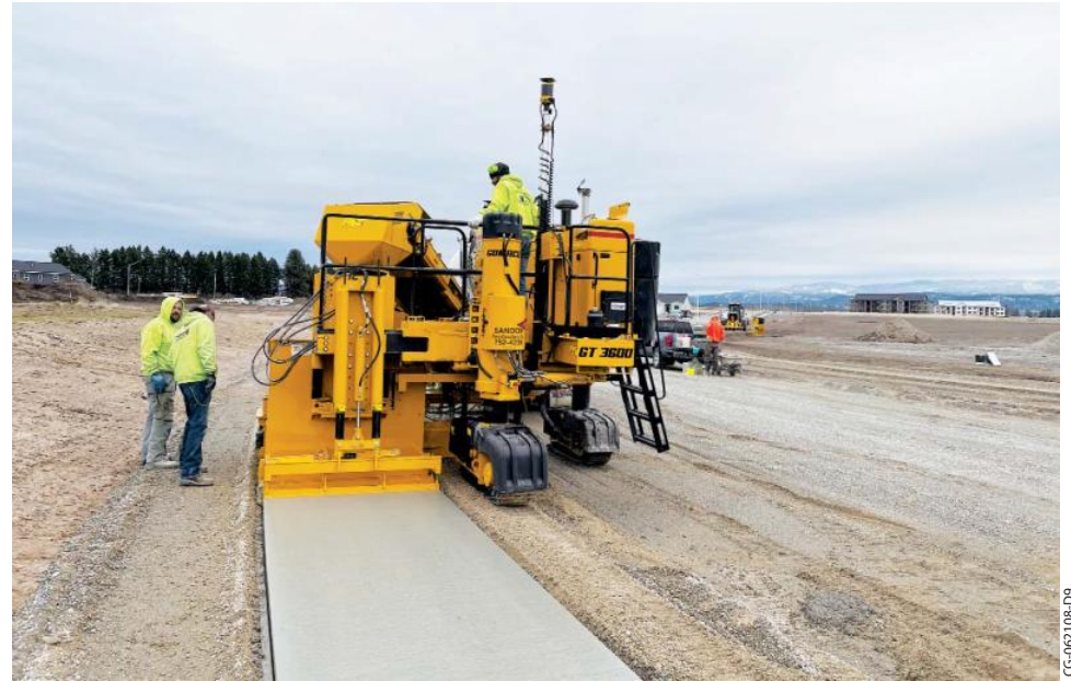
オペレーター用プラットフォームと安全手すりは、側面に取り付けられたモールドとともに伸縮し、オペレーターが作業全体を見渡せるようになっています。このGT-3600は、幅5フィート（1.52m）の歩道を打設しています。
