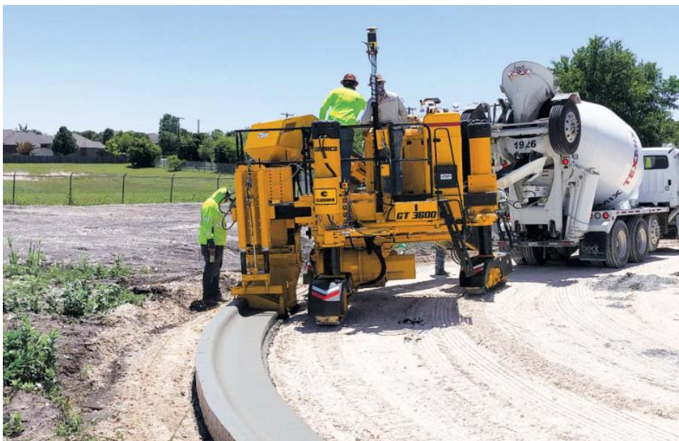
GT-3600のトリマーは最大で48インチ（1219mm）の油圧サイドシフト距離を持っており、オペレーターは住宅地地域内の障害物から数インチのところまでカーブアンドガッターを打設することができます。
