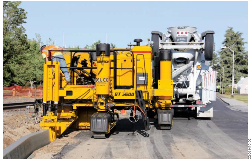
GT-3600が、スタンドアップカーブを打設しています。
