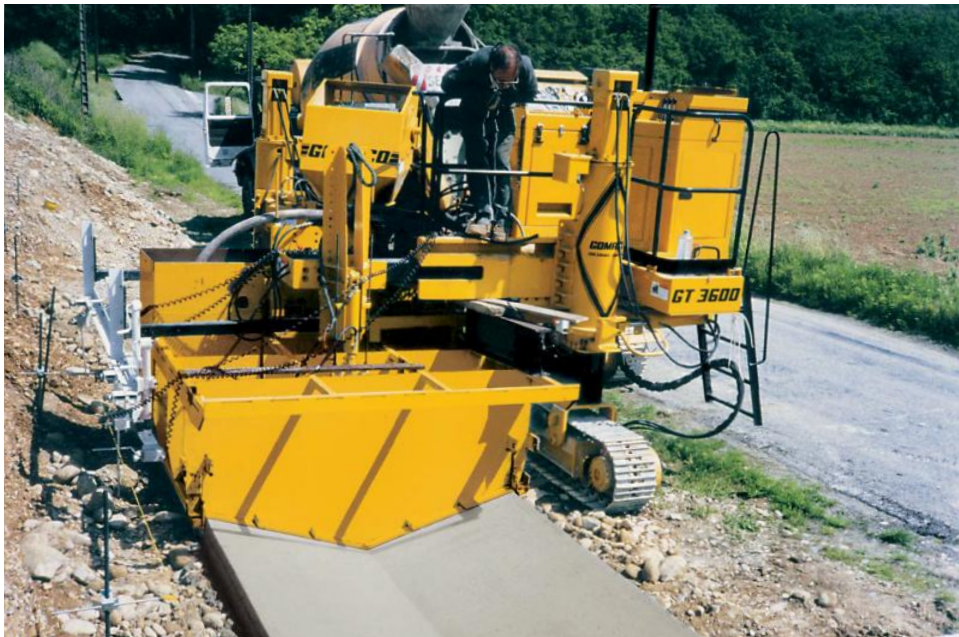
万能なGT-3600が、フランスで排水溝を打設しています。サイドマウントの設計により、モールドの左側の最小クリアランスを実現することができます。
