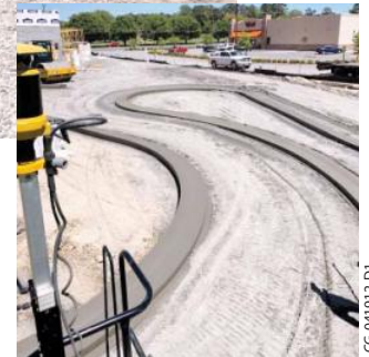
GT-3600のステアリング性能と3Dマシンガイダンスを使えば、駐車場の建設も容易に行うことができます。センサー付きオールトラックステアリングとオールトラックポジショニングにより、エクストリームGT-3200は究極で賢いスリップフォームカーブアンドガッターマシンになりました。
