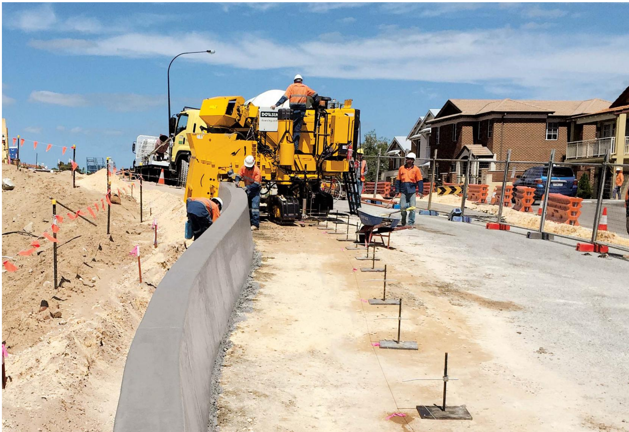
このGT-3600は、オーストラリア、パース州でのプロジェクトで、高さ34.8インチから50インチ（885mmから1270mm）の可変バリアを打設しています。
