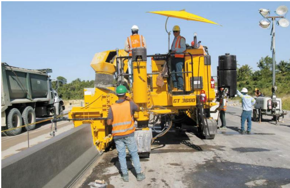
オプションのサイドマウントバリアとパラメットアタッチメントにより、GT-3600は最大高さ50インチ（1270mm）まで打設を行うことができます。
