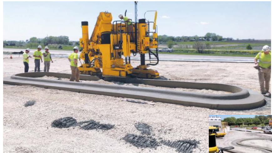
GT-3600のステアリング性能と3Dマシンガイダンスを使えば、駐車場の建設も容易に行うことができます。センサー付きオールトラックステアリングとオールトラックポジショニングにより、エクストリームGT-3200は究極で賢いスリップフォームカーブアンドガッターマシンになりました。
