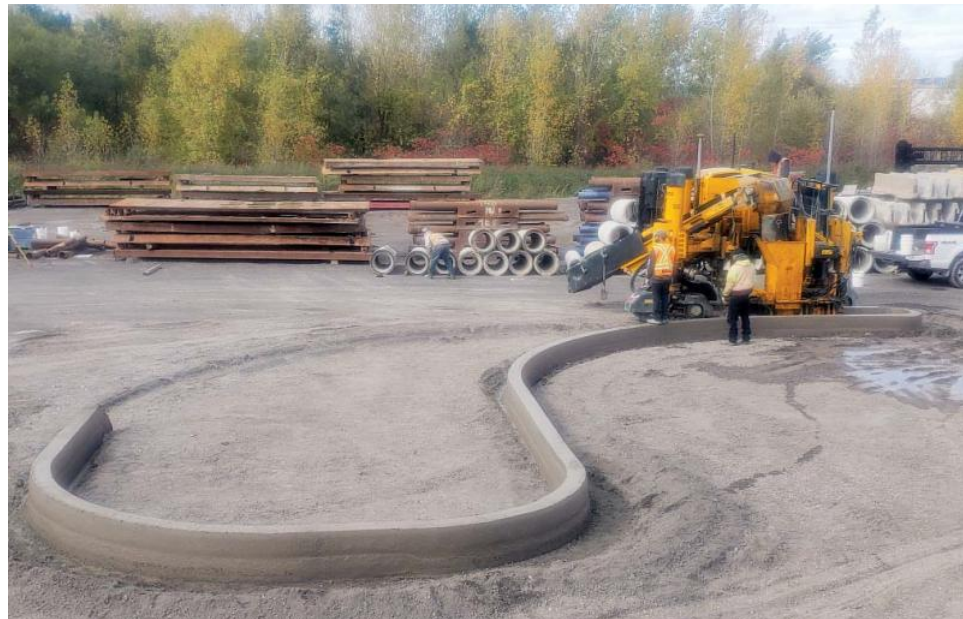
エクストリームGT-3600は、3Dマシンガイダンスを使用して、狭いラジアスのスタンドアップカーブを打設しています。
