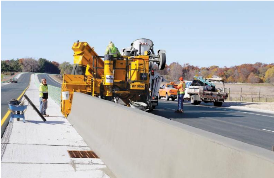
GT-3600が、44インチ（1118mm）の中央バリアを打設しています。
