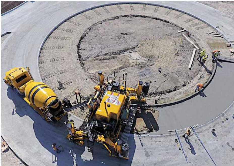
このGP3は、環状交差点の内側に高さ8インチ(203mm)の縁石を備えた幅12フィート(3.66m)のトラックエプロンを打設しています。G+コントロールシステムにより、GP3は半径の内側と外側で適切なトラック速度を維持することができます。
