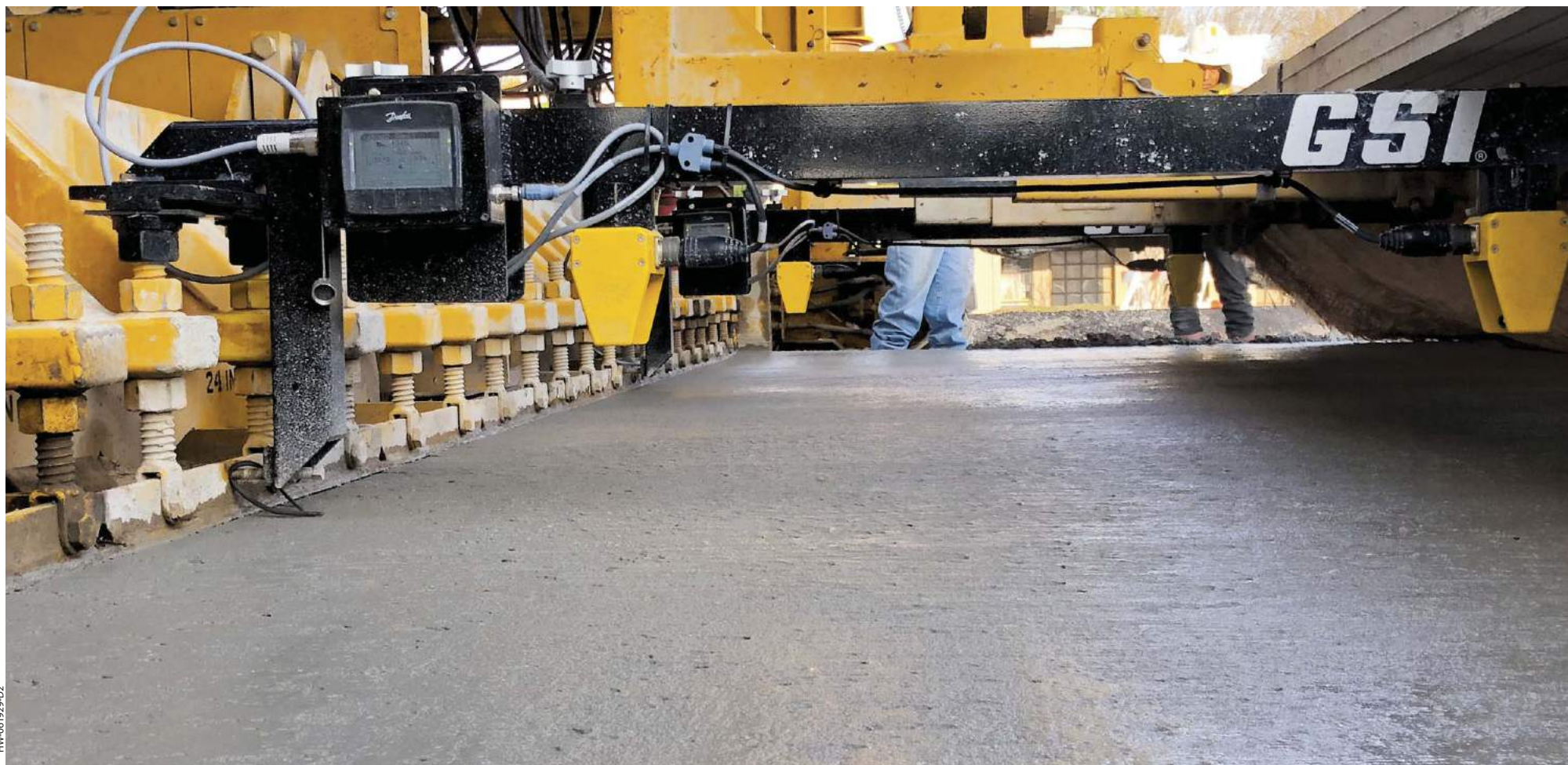
再設計された薄型のマウントシステムにより、ワークブリッジをGSIトレースユニットの上に設置することができます。
