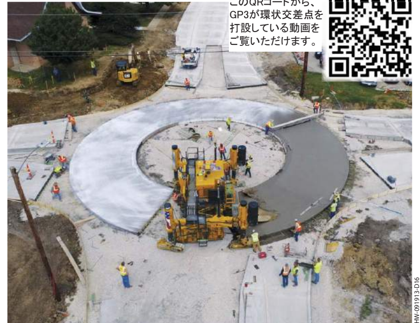
3Dマシンガイダンスを搭載したこの4トラックGP3スリップフォームペーバは、幅18フィート(5.49m)、内半径22フィート(6.71m)の環状交差点を打設しています。
