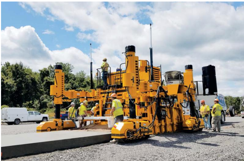
3Dマシンガイダンスを装備した4トラックGP-2400を使って、高速道路の本線の打設が行われています。
