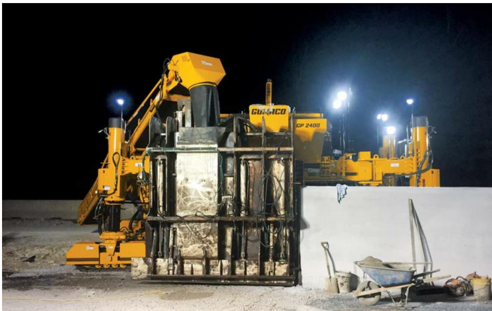
回送モードに移行すると、4トラックGP-2400は最大で7フィート(2.13m)の防護柵を打設することができます。
