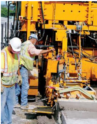
スリップフォーム打設が開始されると、トレーリングフォームは下がり、手動のバー挿入を再開します。
