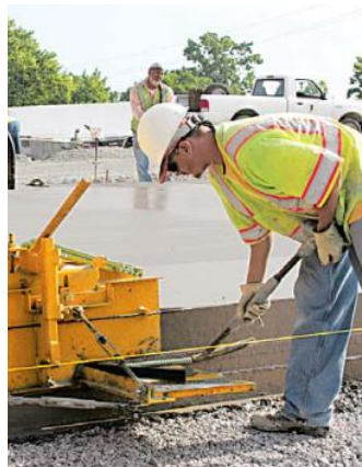
スリップフォーム打設が開始されると、トレーリングフォームは下がり、手動のバー挿入を再開します。
