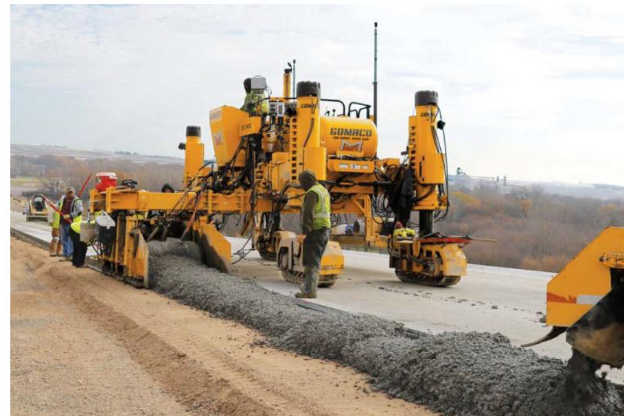
サイドマウント式モールドを装備したこのGP-2400は、3Dマシンガイダンスを使用して路肩を打設しています。
