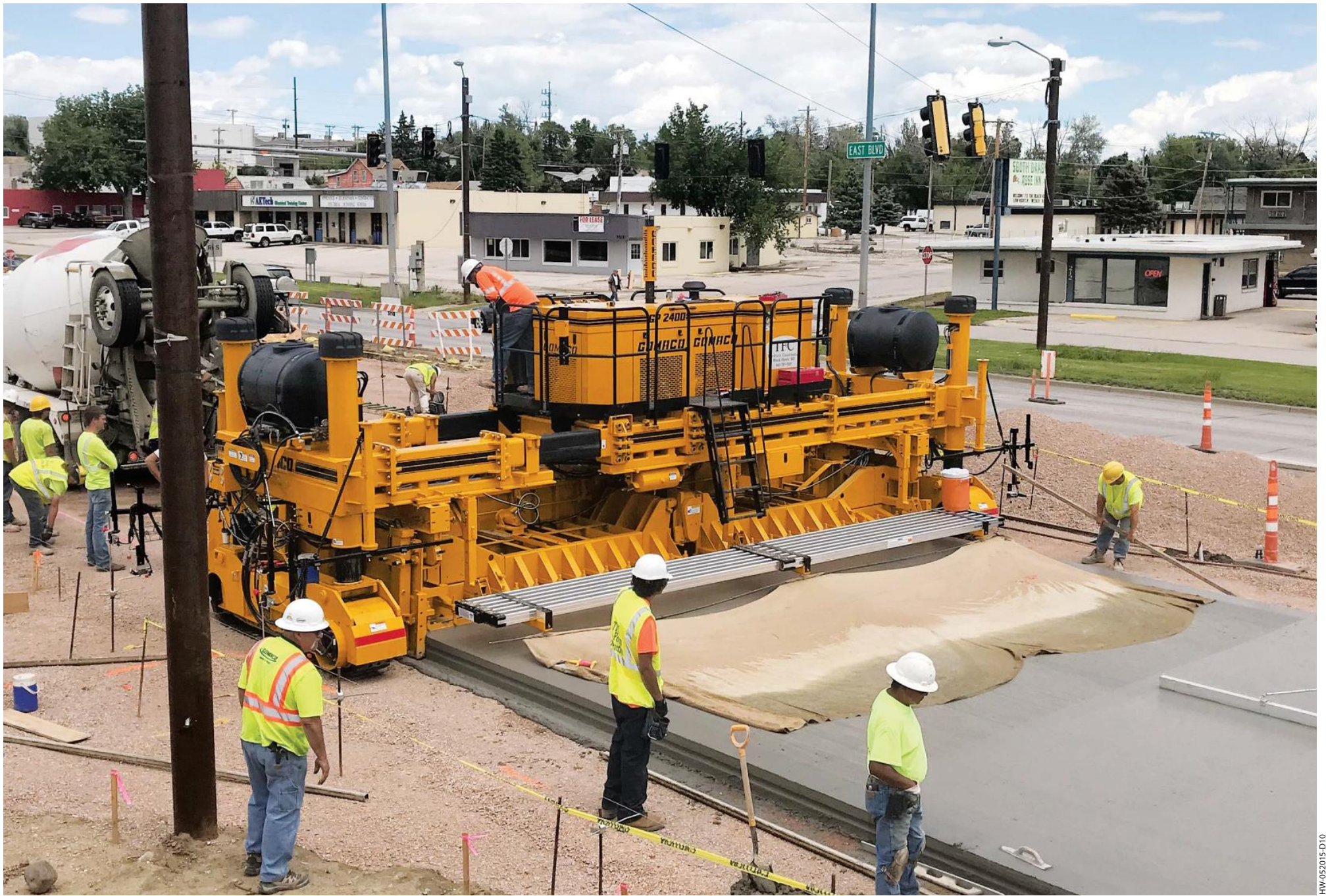
GP-2400は、狭い市街地でも最大24フィート(7.3m)の幅で舗装できるため、自治体向けの舗装機として最適です。2トラックGP-2400が、既存の障害物の間を縫うように移動しながら、メス型キーウェイを備えたこの新しい市道をスリップフォーム施工しています。
