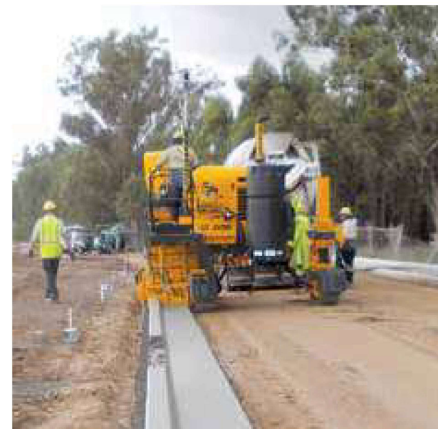
GT-3200のモールドは、カーブアンドガッターを打設する際にオプションのカーブディプレッサーを搭載することができます。
