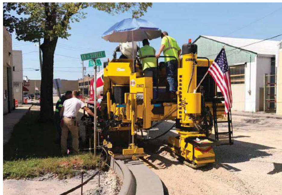
このコマンダーIIIxは、住宅地にてカーブアンドガッタを打設しています。
