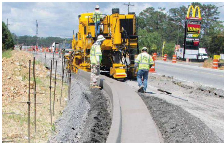
コマンダーIIIxの特徴は、オペレータが一日中スリップフォーム舗装を快適に作業できるように、滑りにくく防振性に優れたプラットフォームを備えています。
