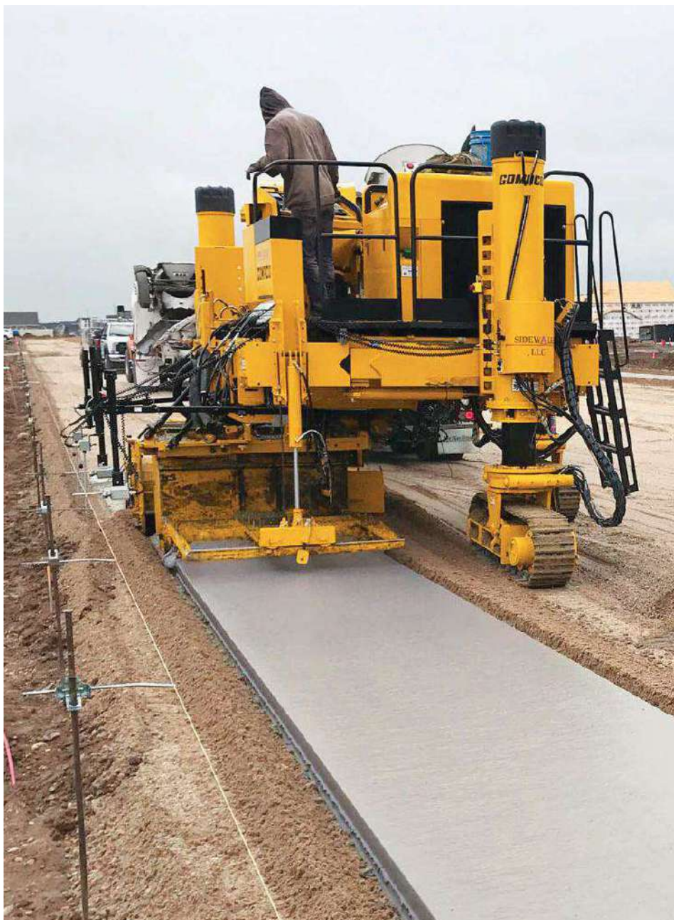
この現場では、新興住宅地開発地域にて、5フィート(1.52m)幅員の歩道を打設しています。材料の特性を最大限に活かすため、3トラックコマンダーIIIxで施工を行っています。
