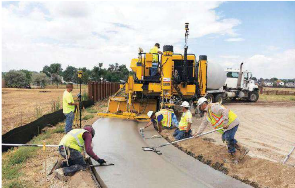
このコマンダーIIIxは、3Dマシンガイダンスを使用し、新しい区画内で歩道とカーブアンドガッタを打設しています。
