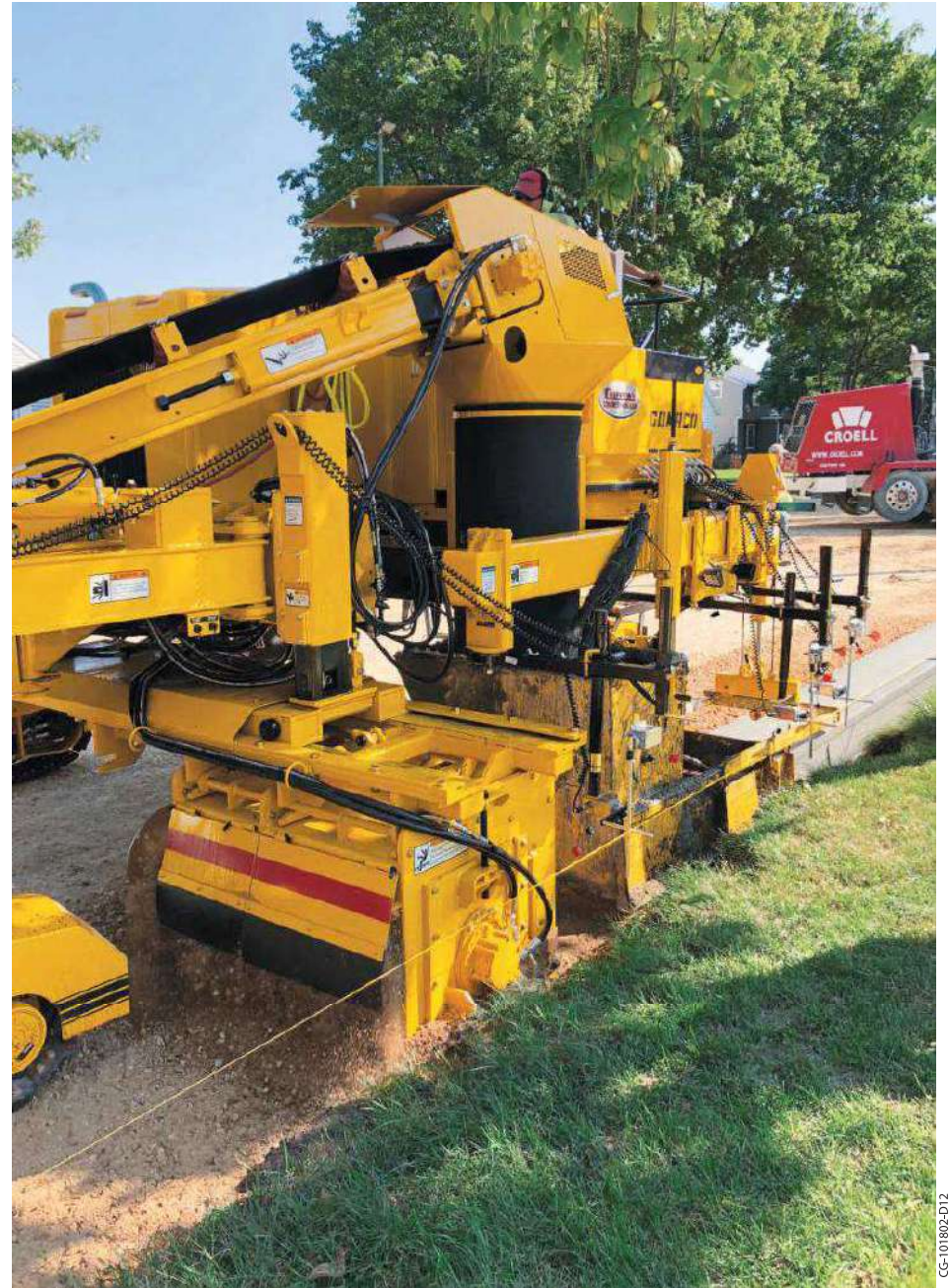
3トラックコマンダーIIIxを使うと、グレードのトリミングとカーブアンドガッタの打設を同時に行うことができます。
