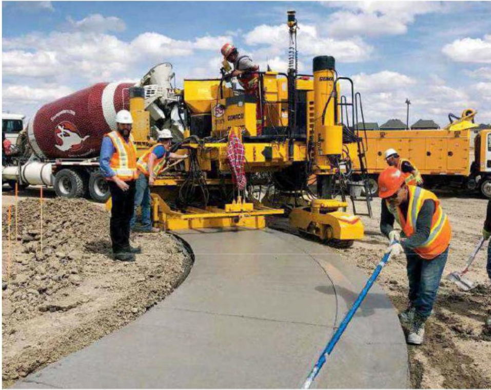
この3トラックコマンダーⅢは、モノリシックサイドウォークと、カーブアンドガッタを打設しています。
