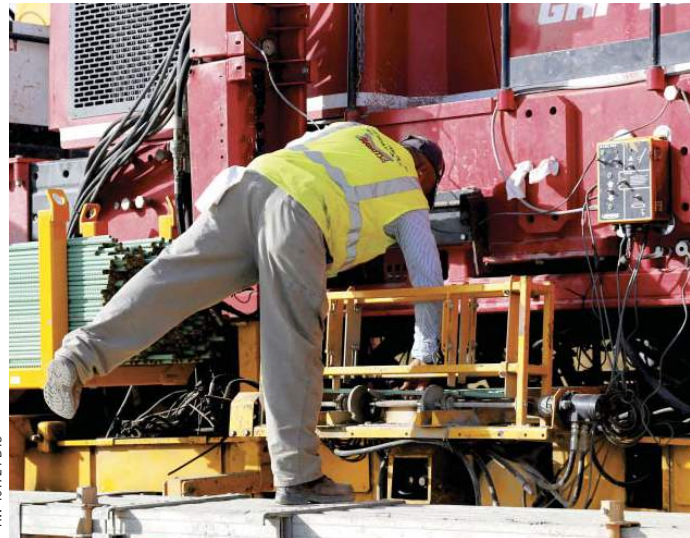
GOMACOのサイドプレートエクステンションと油圧システム バーインサーター
