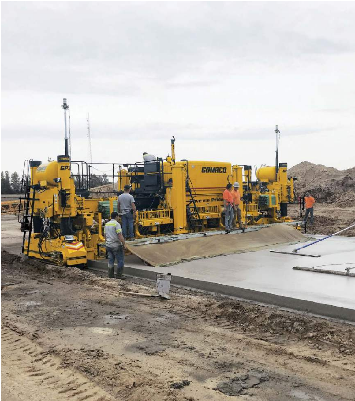
この2トラックGP3は、3Dマシンガイダンスを使用してスラブの両側に一体型縁石を持つ道路を打設しています。また、本マシンはGOMACOリモート診断 (GRD) を搭載しており、携帯電話やパソコンからマシンの管理を行えます。
