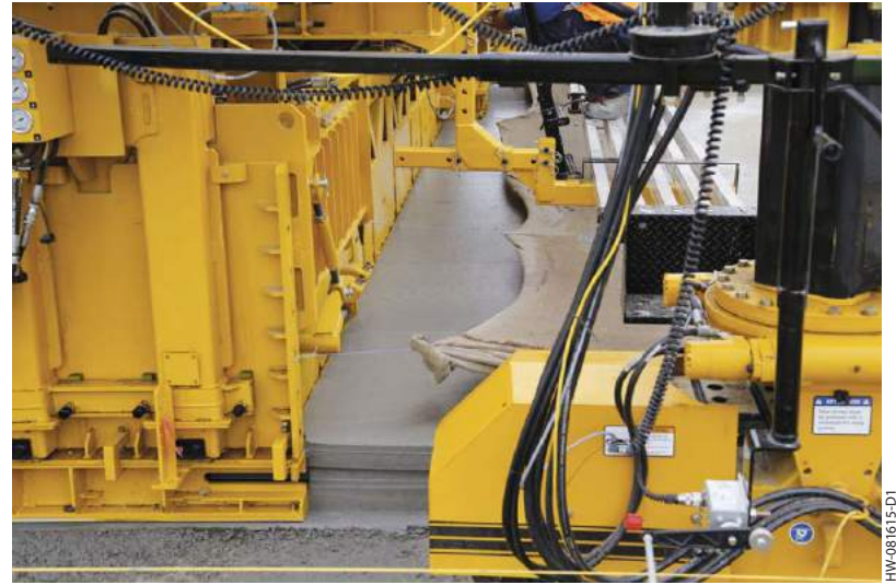
5400シリーズモールドを使用したこのGP3は、商業開発用の新しい道路建設現場にて、滑らかできれいなエッジとキーウェイを完成させました。
