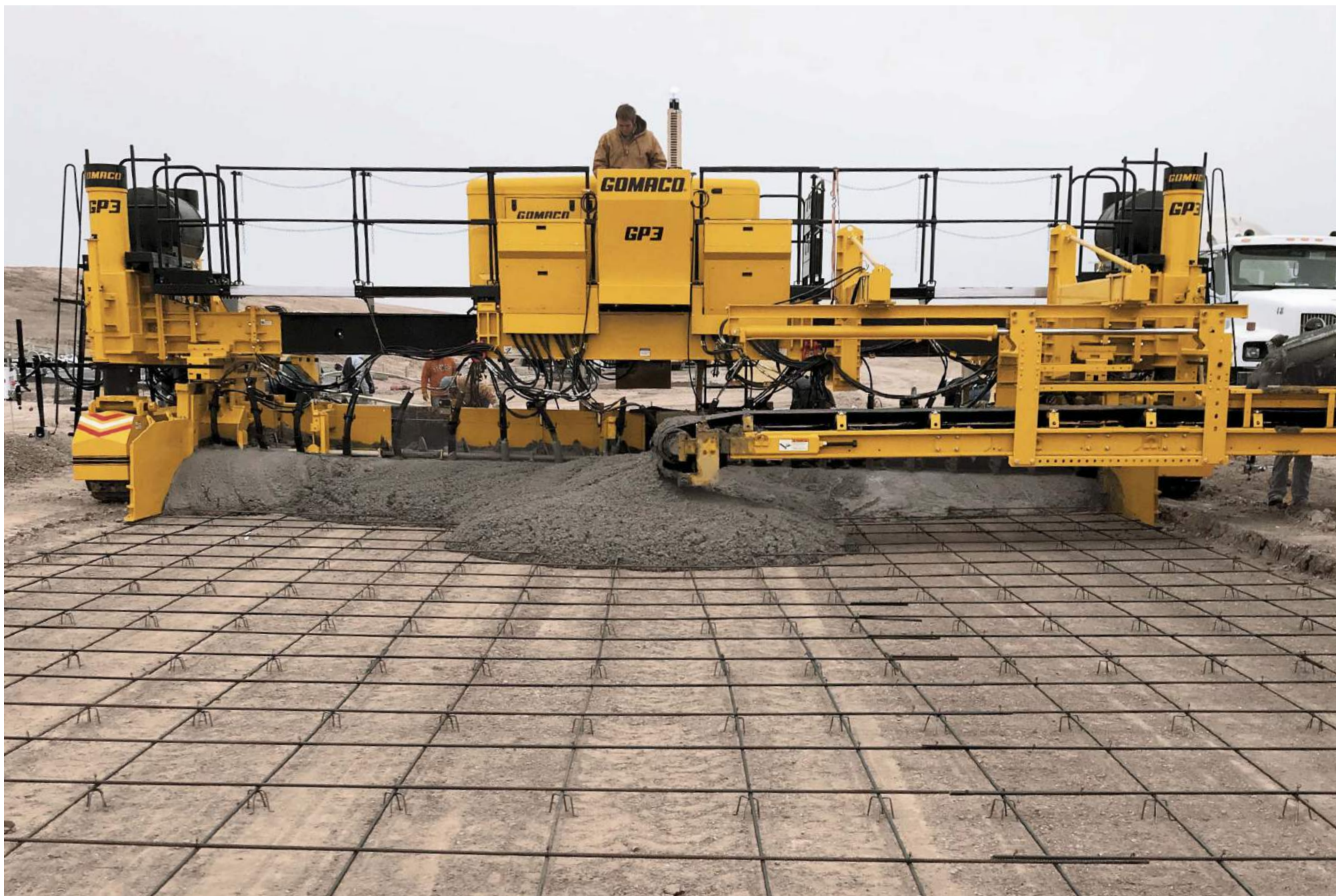
この2トラックGP3には、コンクリート打設のために特別な前面コンベアベルトが取り付けられました。グレードに敷設された連続補強鉄筋により、コンクリートトラックがマシンの前に入ることができなかったため、トラックはペーパーの左側からコンクリートを供給しました。
