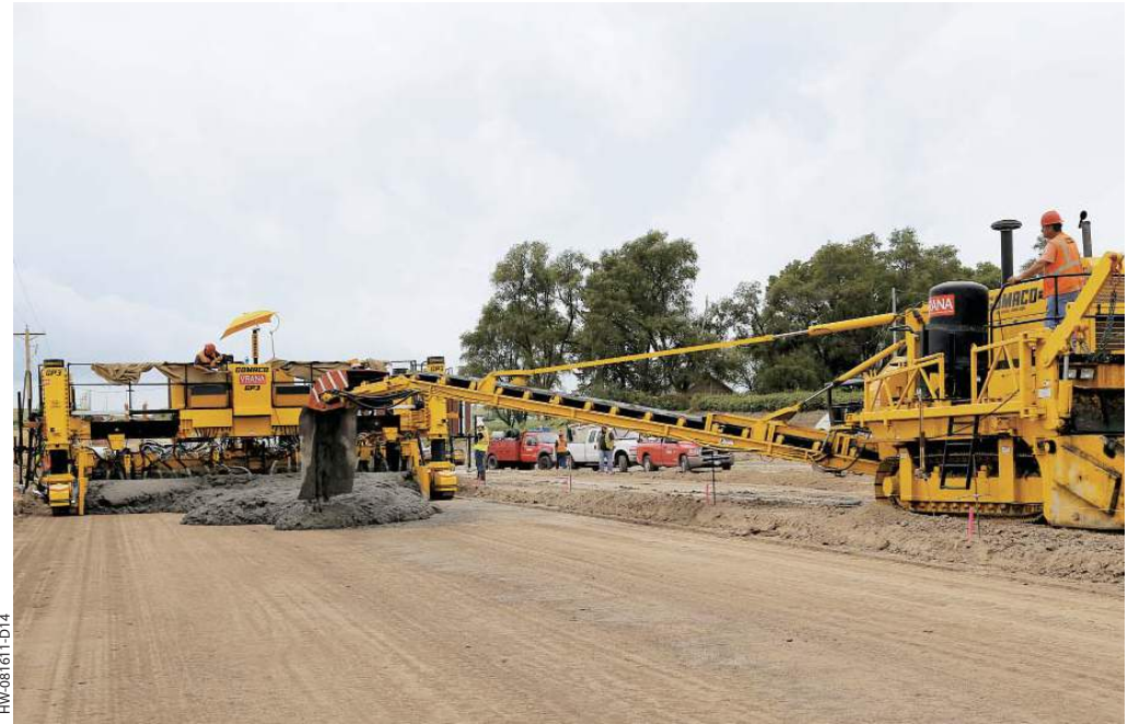
4トラックのGP3が、幅員25フィート(7.62m)の道路を打設しています。スリップフォームペーパーの前方では、9500プレーサーがコンクリートを供給しています。
