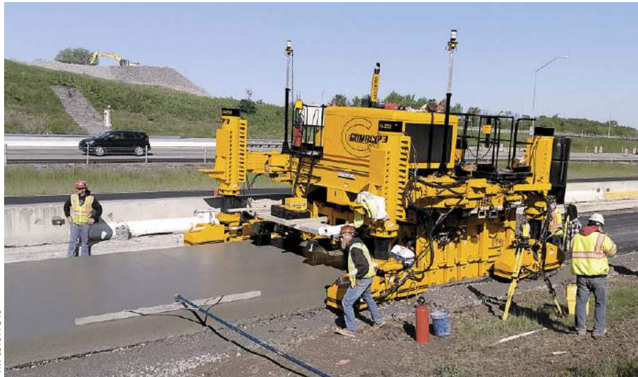
3Dマシンガイダンスとペーパー搭載型GSI®(GOMACOスムースネスインジケーター)を2台装備したこのGP3は、幅15フィート(4.57m)の高速道路をスリップフォーム舗装しています。
