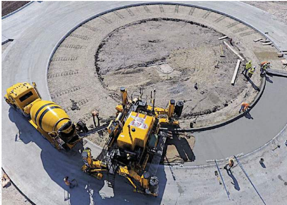
このGP3は、環状交差点の内側に高さ8インチ(203mm)の縁石を備えた幅12フィート(3.66m)のトラックエプロンを打設しています。G+コントロールシステムにより、GP3は半径の内側と外側で適切なトラック速度を維持することができます。
