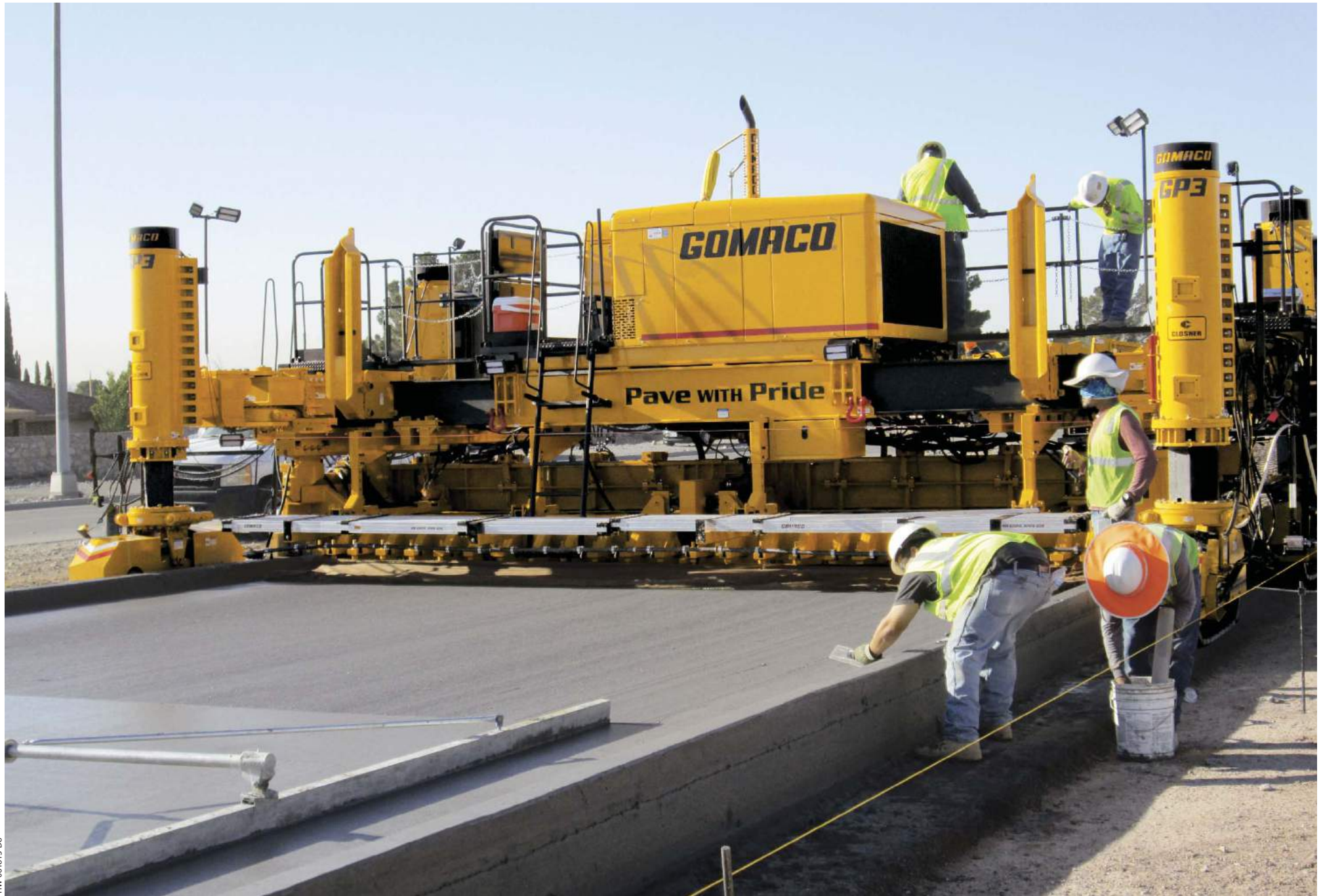
5000シリーズパビングモールドを装備したこの4トラックGP3は、スラブの両側が縁石と一体化した幅26フィート(7.92m)の道路を打設しています。
