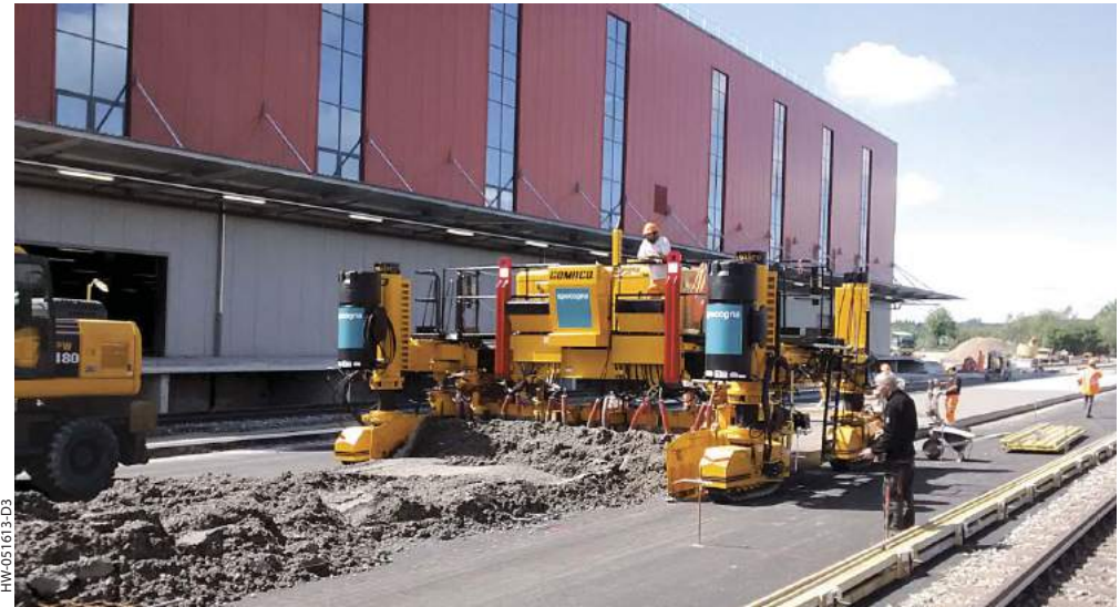
この4トラックGP3は、16.4フィート(5m)の荷物搬入口を打設しています。
