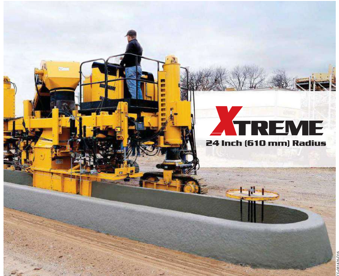
GOMACOコマンダーIIIxとG+コントロールシステムをストリングラインまたは3Dマシンガイダンスシステムと使用することで、最小610mm(24インチ)までの半径を施工できるようになりました。
