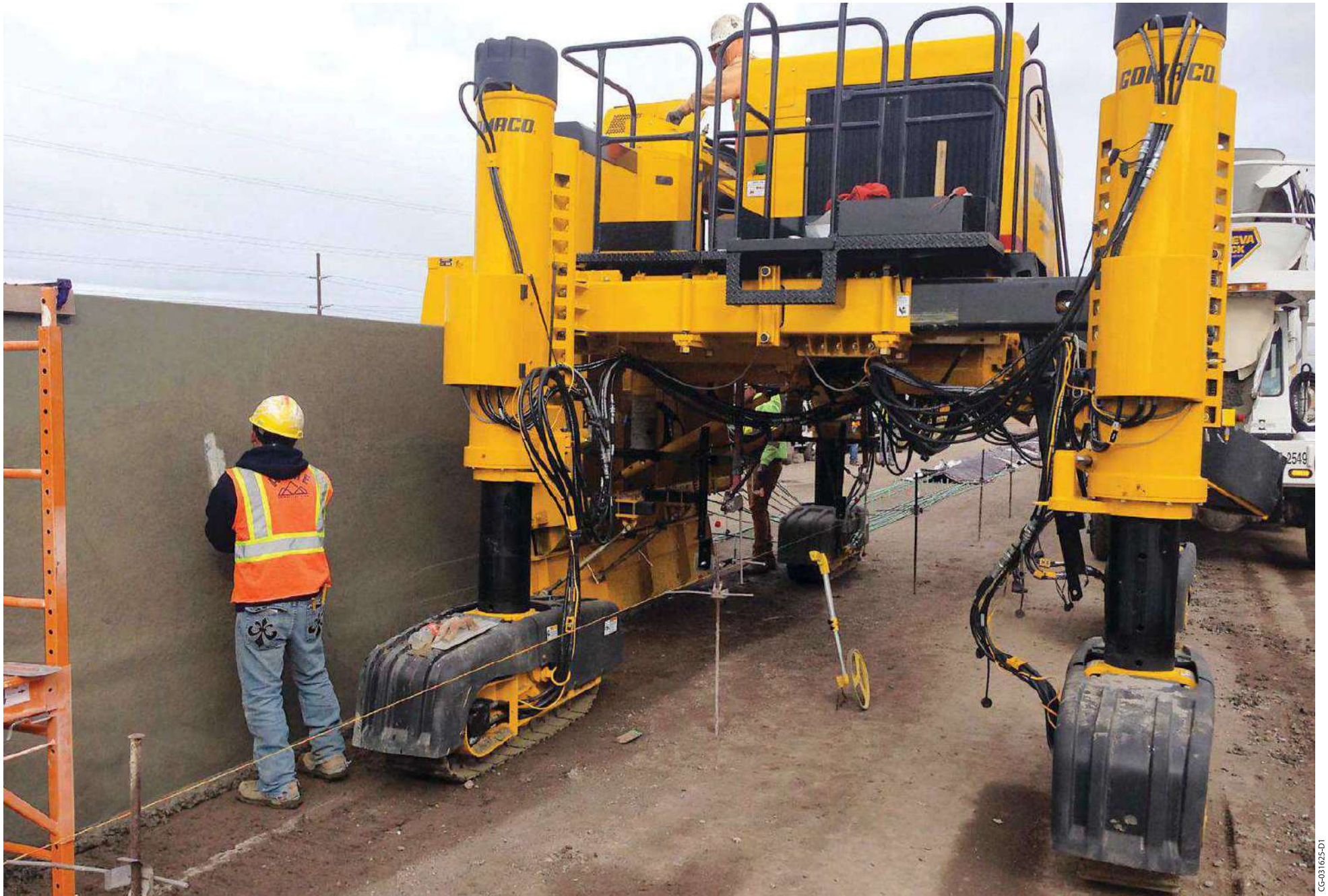
このバリアパッケージ付きの4トラックコマンダーIIIは、7フィート (2.13m)の防護柵を打設しています。
