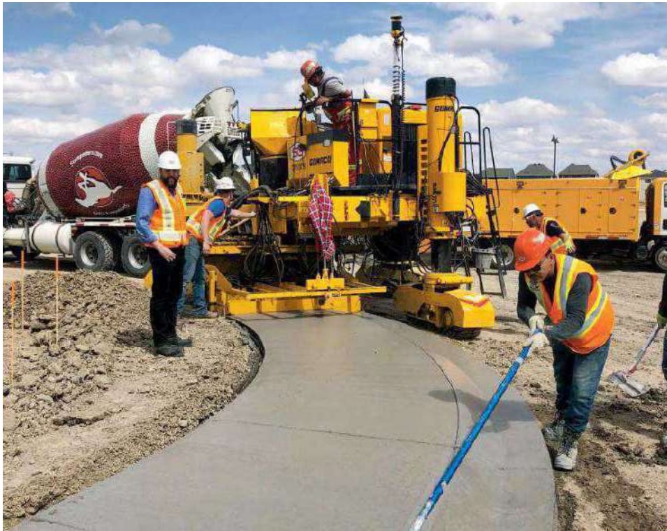
この3トラックコマンダーIIIは、モノリシックサイドウォークと、カーブアンドガッタを打設しています。
