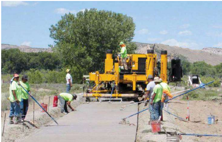
このコマンダーIIIxは、10フィート(3.05m)幅員の自転車道を打設しています。
