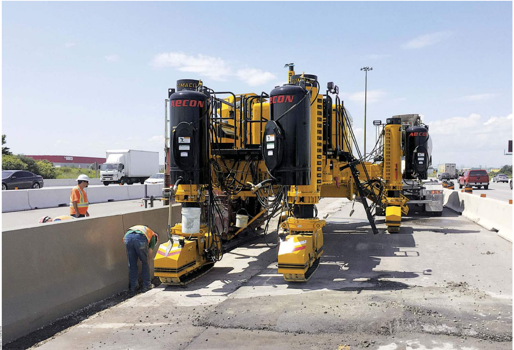
この4トラックGP3は、ペーパーの横に取り付けたモールドとエンドカーに取り付けたコンベアベルトで、可変防護柵を打設しています。
