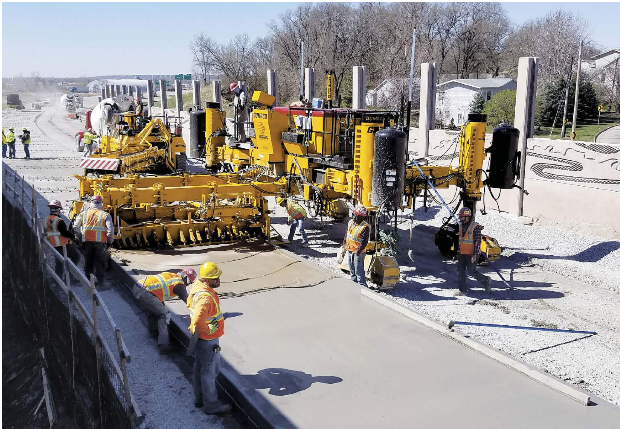
回送モードのGP3にサイドマウントモールドを装備すると、最小のクリアランスで施工を行うことができます。こちらは、米国の州間高速道路の現場の様子です。
