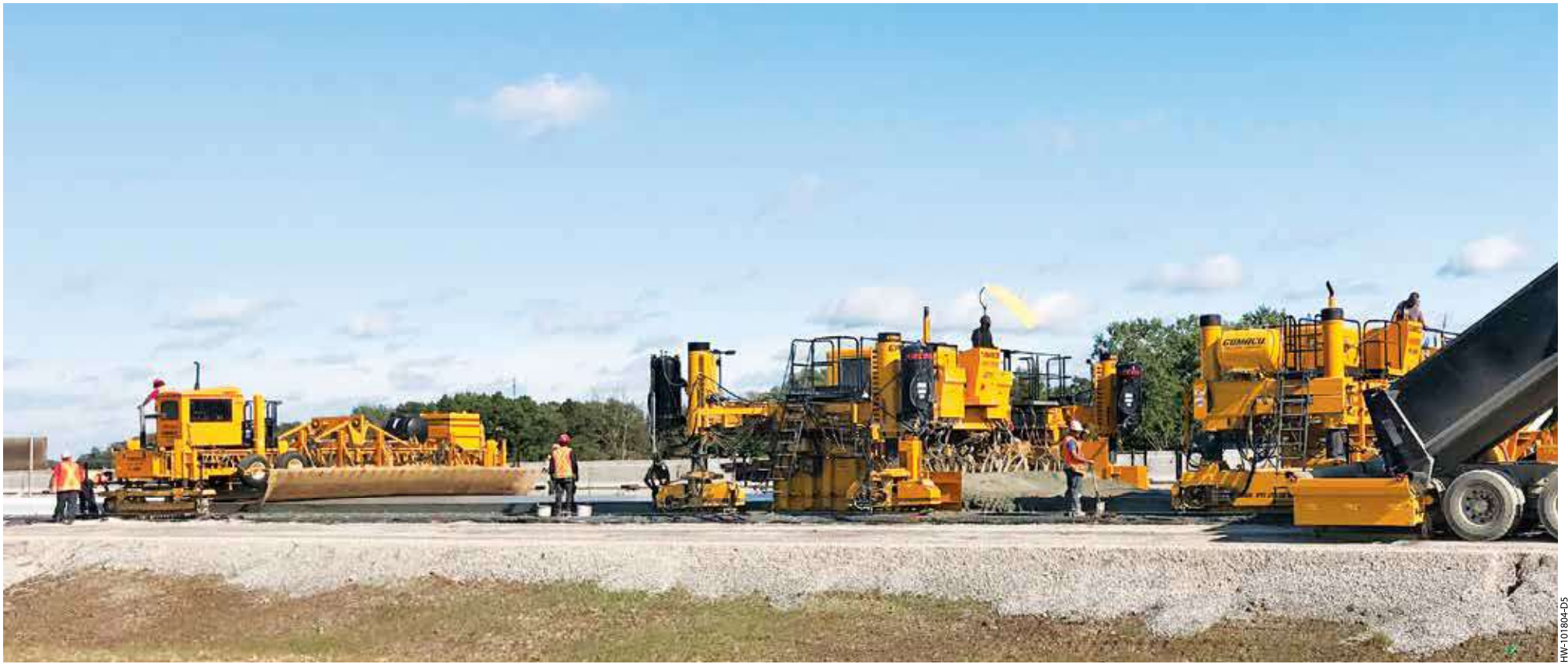
このT/C-600は、PS-2600プレーサ/スプレッタとGP3スリップフォームペーパーの後ろで表面処理と養生を行っています。
