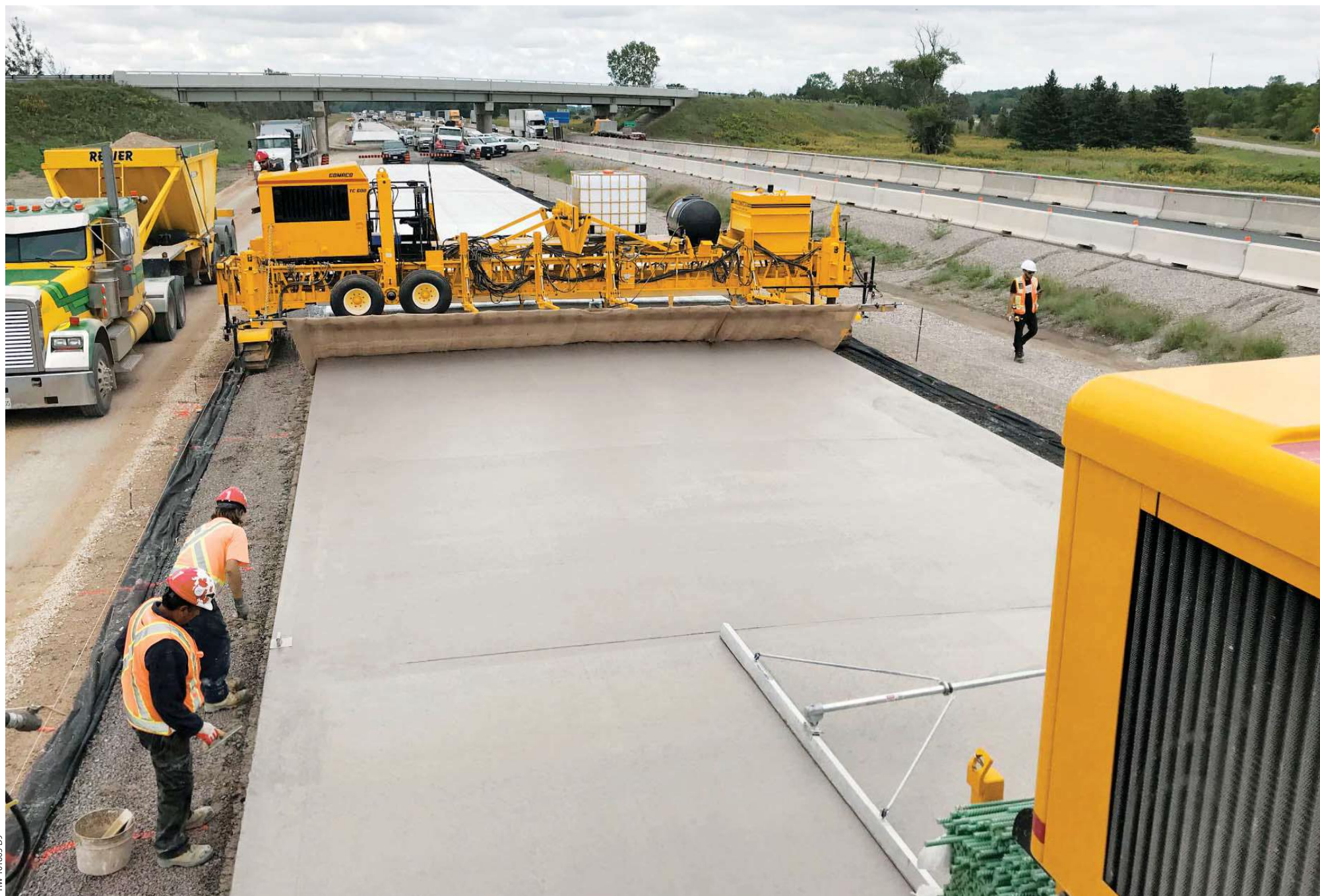
このT/C-600は黄麻布を装着しており、高速道路建設の仕様に必要な表面仕上げを行ってから養生材を塗布しています。
