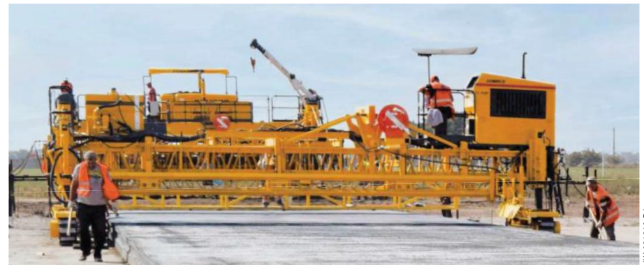
このT/C-600テクスチャ/キュアリングは、GOMACOスリップフォームペーパーの後ろで施工し、空港滑走路のプロジェクトを完成させました。
