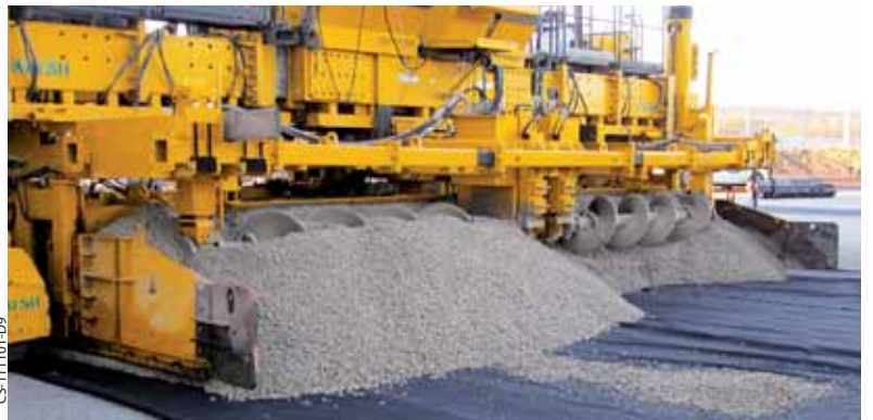
このPS-2600は、セメント処理されたベースの配置と拡散を行っています。装備した7500シリーズプレーサモールドは、10インチ(254mm)の油圧シリンダ式垂直調整機能を備えています。
