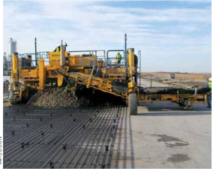
このPS-2600プレーサ/スプレッダは、テキサス州の有料道路で、連続鉄筋の上にコンクリートを配置しています。
