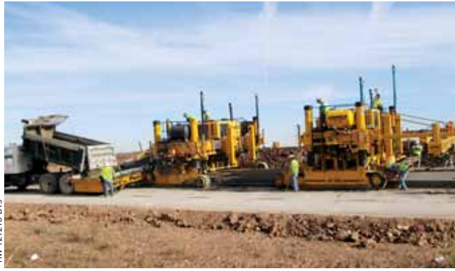
このGOMACOペービングトレインは、PS-2600とGHP-2800の編成で、トプコン社製3Dマシンガイダンスシステムを使用しています。
