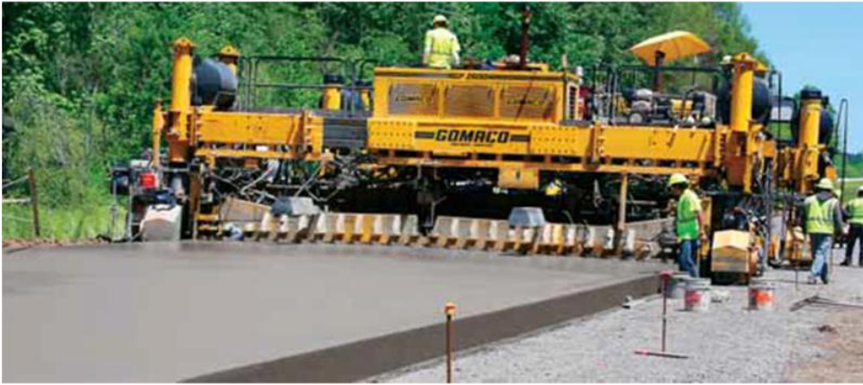
ライダーリティー要求仕様にチャレンジする為にペービング・プロセスをファイン・チューニングするのに使用しました。
