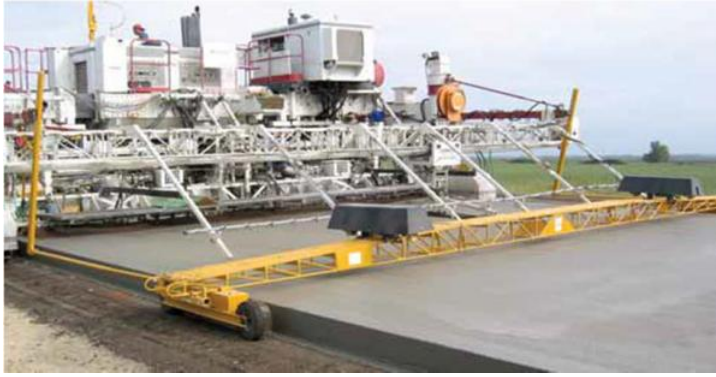
GSIユニットはGOMACOスパニット・ワークブリッジに搭載可能です。これらの写真ではワークブリッジはGOMACO GHP-2800スリップフォーム・ペーパーの後に取付けられています。
