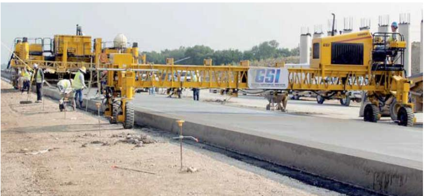
米国のセントラル・テキサス・ターンパイクで、仕上げ機直後でGOMACO GP-4000をフォローするGSIマシン。GSIが4つの異なるトレースから同時に平坦性を読取り、そのデータを使ってスラブの計測を確定します。
