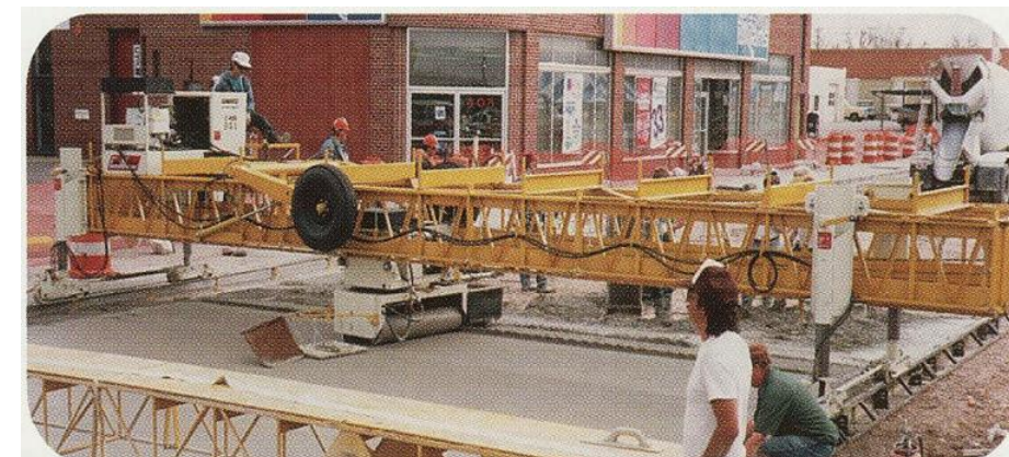
2機のシリンダーとオーガを搭載、ダブル・ドラム施工。
