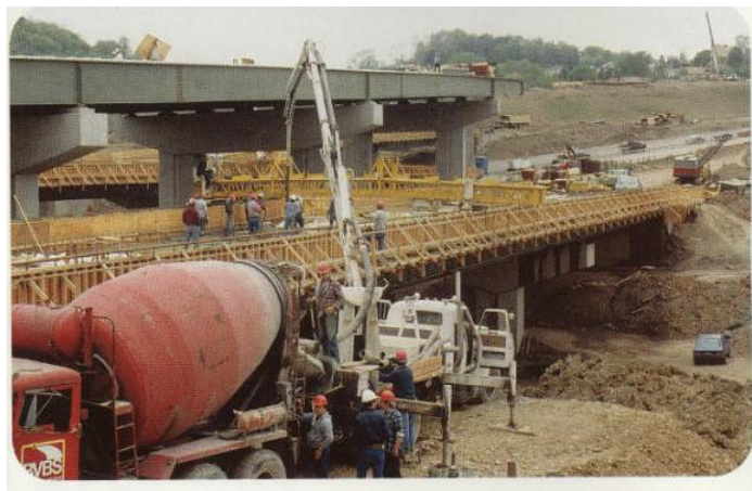
この橋梁デッキの C-450 には、ピン接続の部分に、二つの PTA が搭載されています。クラウン調整が可能です。
