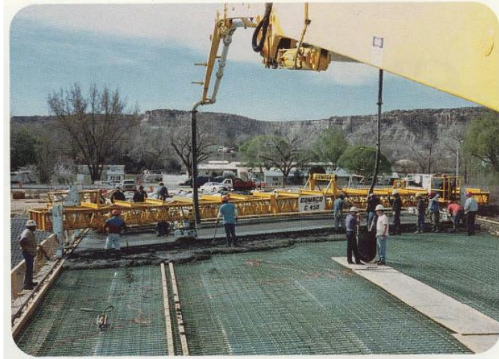
この C-450 は 21.95m の橋梁デッキの仕上げを行なっています。フィニッシャには、調整可能オーガ付きのダブル・ドラム・キャリッジが搭載されています。
