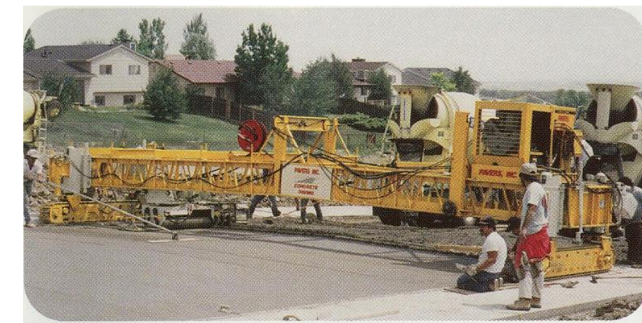
本機は、3.35m 2セクション構成で、シリンダーは、油圧式。クローラ・タイプ。ステアリング、グレード等自動制御が可能です。
