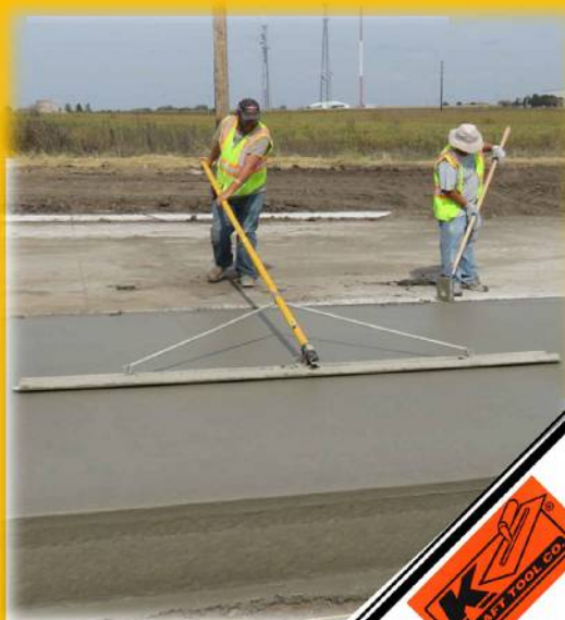
↑各写真はフロートパン長さが2,440mmのプレス付タイプです。↓
